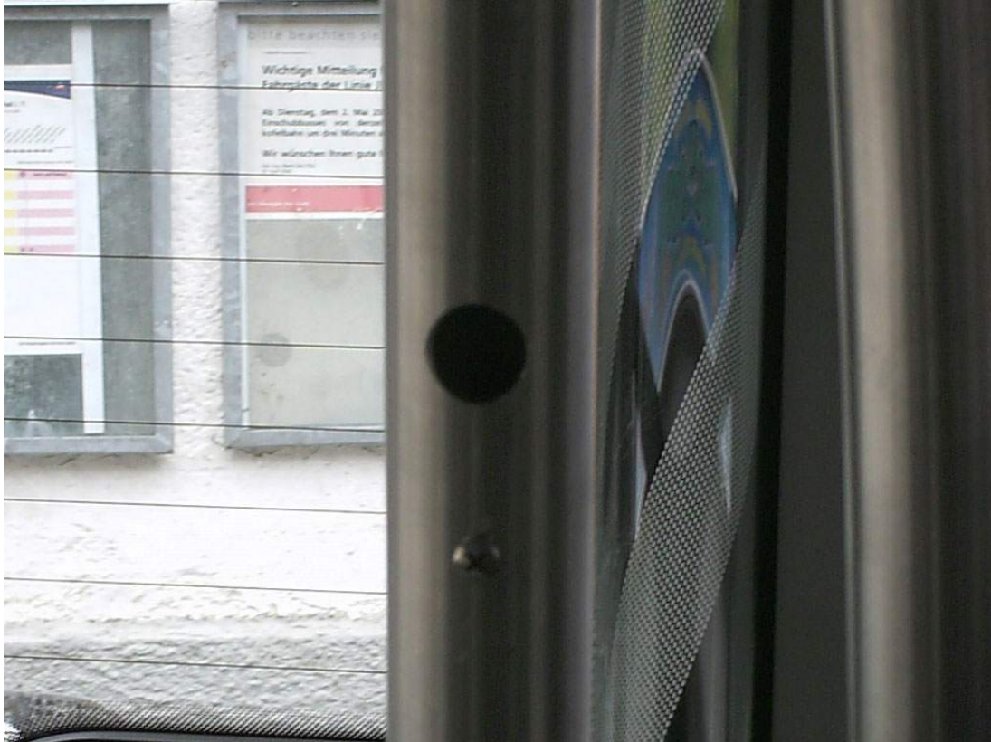
Bild 2: Wo eine Haltewunschttaste sein sollte, ist schon seit Monaten in einem Bus der Firma Heiss nur noch ein Loch. Reparatur wird nicht von der VTG bezahlt.
